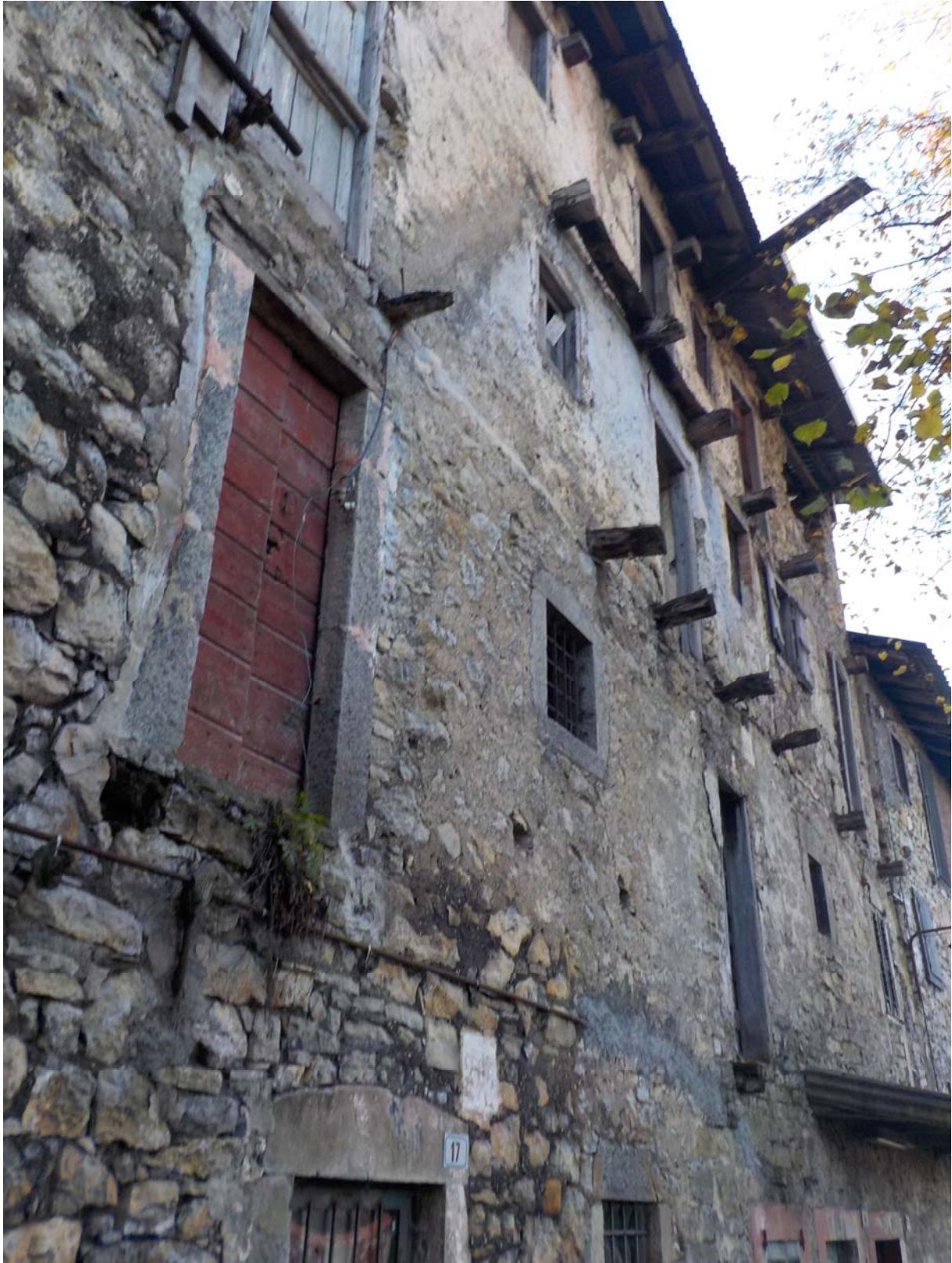
Des maisons d'importance. Les balcons de bois n'existent plus depuis longtemps, si bien que les portes donnent aujourd'hui sur le vide.
